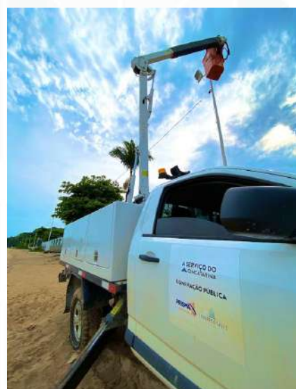
Serviço de manutenção da iluminação pública realizado na orla de Biguaçu/SC
