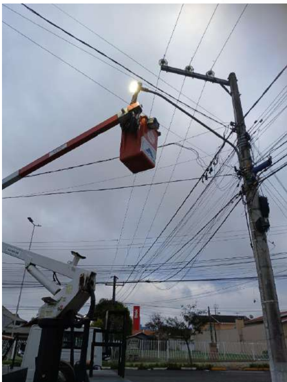
Serviço de modernização, com instalação de luminária LED, realizado pela empresa Tradetek, em Lages/SC.
