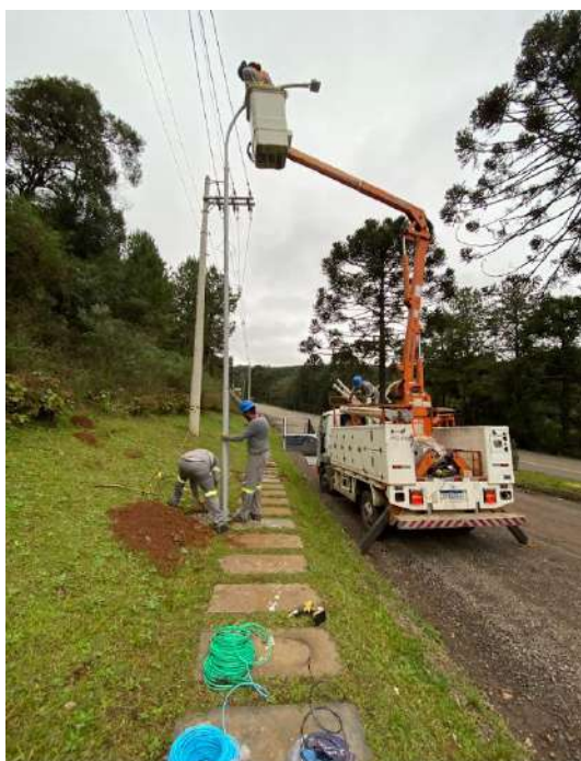
Instalação de postes ornamentais e luminárias LED, na entrada do Santuário Nossa Senhora de Fátima, em Fraiburgo/SC.
