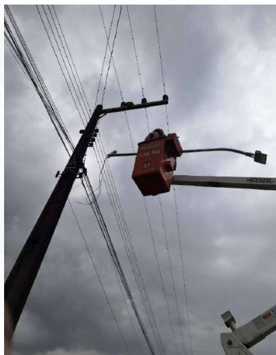
Serviços de modernização, com troca de braço e instalação de luminária LED, realizada pela empresa Versa Engenharia.
