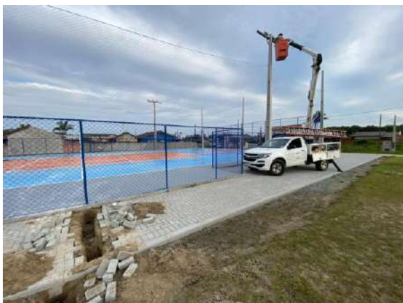
Obra de instalação de refletores LED para iluminação de quadra poliesportiva de praça pública, realizada pelo consórcio TS Prisma, na cidade de Balneário Barra do Sul/SC
