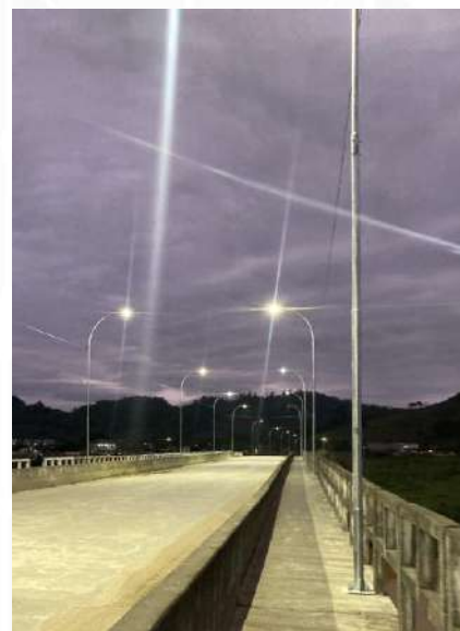
Instalação de postes ornamentais e luminárias LED na ponte do Bananal em Guaramirim/SC
