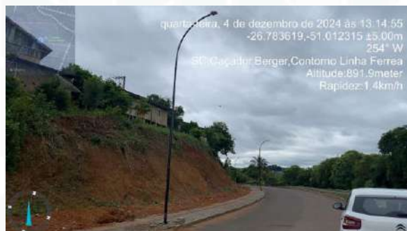
quarta-feira, 4 de dezembro de 2024 às 13:14:55 -26.783619,-51.012315 ±5.00m 254° W SC, Caçador, Berger, Contorno, Linha Ferreira Altitude: 891.9meter Rapidez: 1.4km/h Postes ornamentais instalados pelo Consórcio TS Prisma, na obra do Parque Linear, em Caçador/SC
